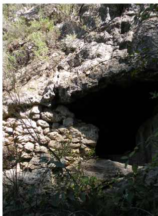
Construcció humana apuntalant una cova. 2010. Fotografia de Lluís Comas, cortesia del CREAM.
