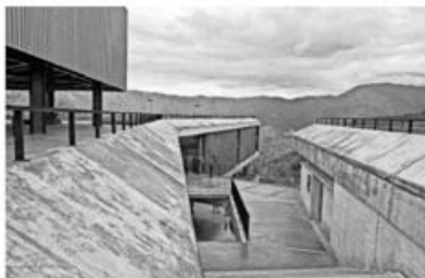
Colegio en Medellín. Levantado en 2008 en la colonia Santo Domingo Savio por Citra-negra Arquitectos, la cubierta del centro escolar es una plaza mirador. ALEJANDRO ARANGO
