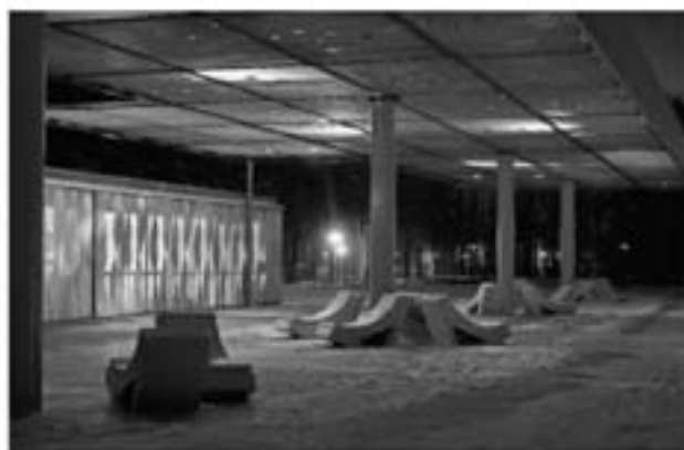
Gasolinera-plaza en Ámsterdam. En 2014, Sophie Valla salvó de la demolición dos gasolineras abandonadas para convertirlas en plazas públicas cubiertas. sophievalle
