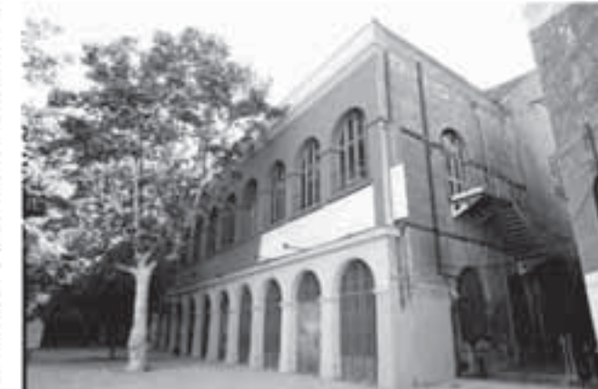
A dalt, una imatge virtual de l'edifici de l'antic teatre rehabilitat. A baix, una imatge de l'edifici obert, a l'espera que comencin aviat les obres. / CCCB i GABRIEL MESSANA
